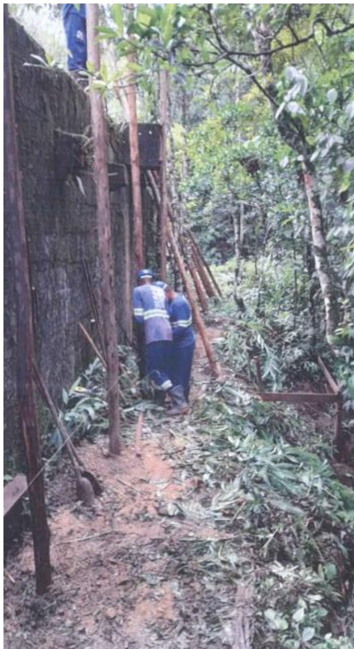
Figura 6.21 Rota 116 – Reforço no muro de contenção – Km 63 Norte
