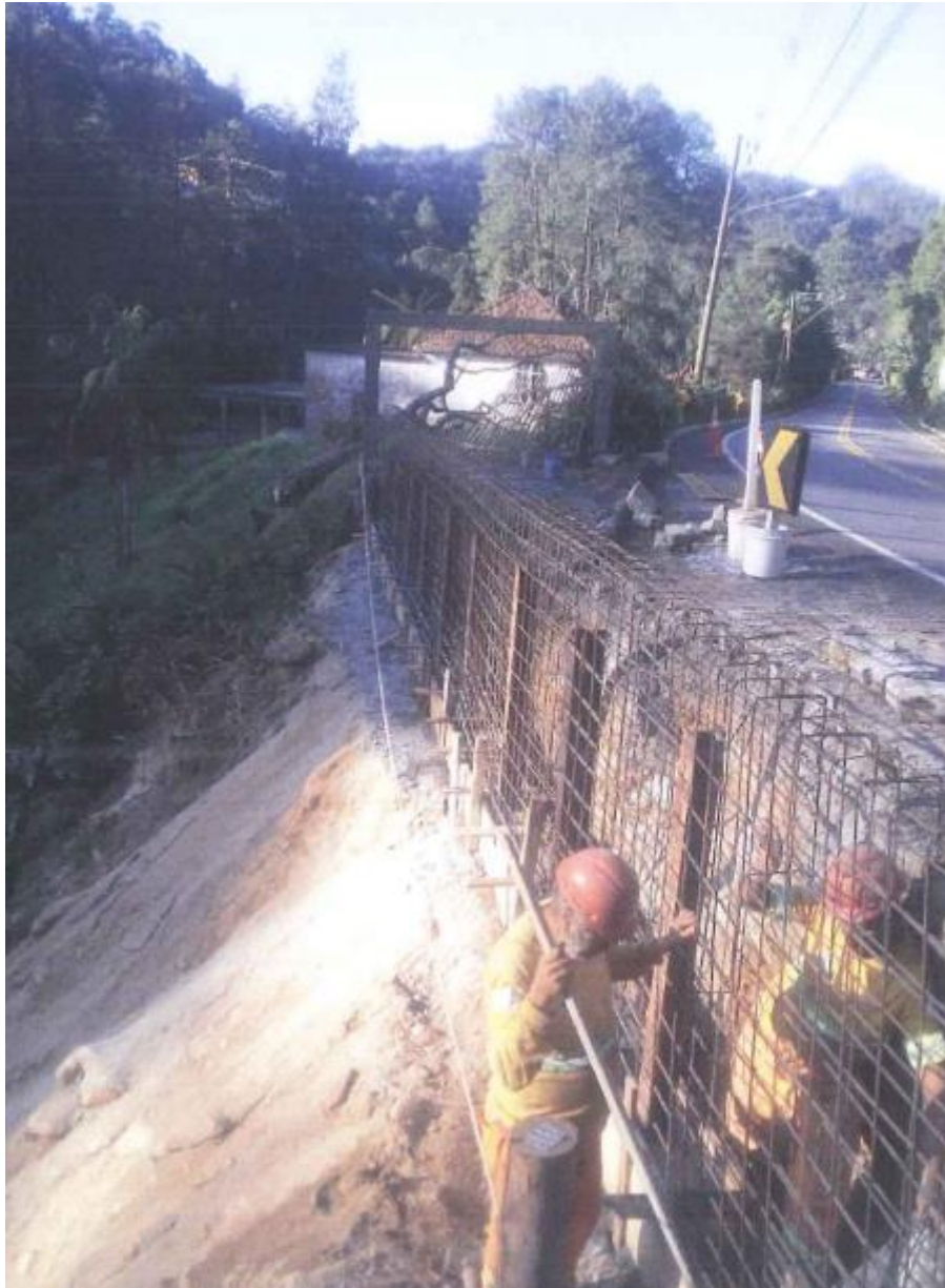
Figura 6.20 Rota 116 – Obra emergencial de contenção – Km 67+800 Sul
