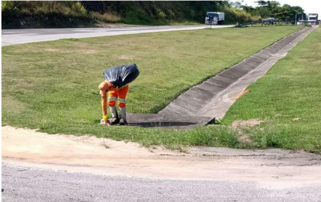
Figura 6.13 Via Lagos – Cata Cata – Km 25+000 Sul
