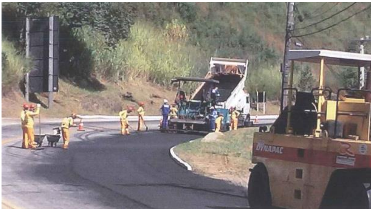
Figura 6.19 Rota 116 – Pavimentação – Km 90
