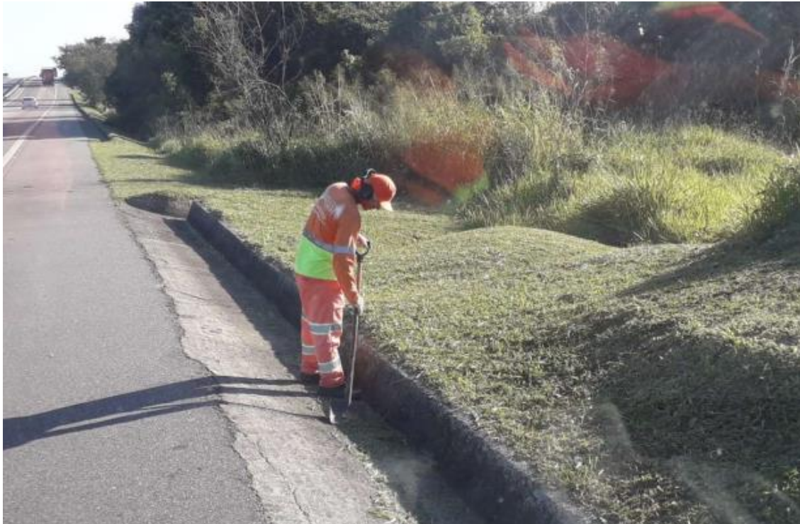
Figura 6.5 Via Lagos – Limpeza de sarjeta – Km 33+000 Sul
