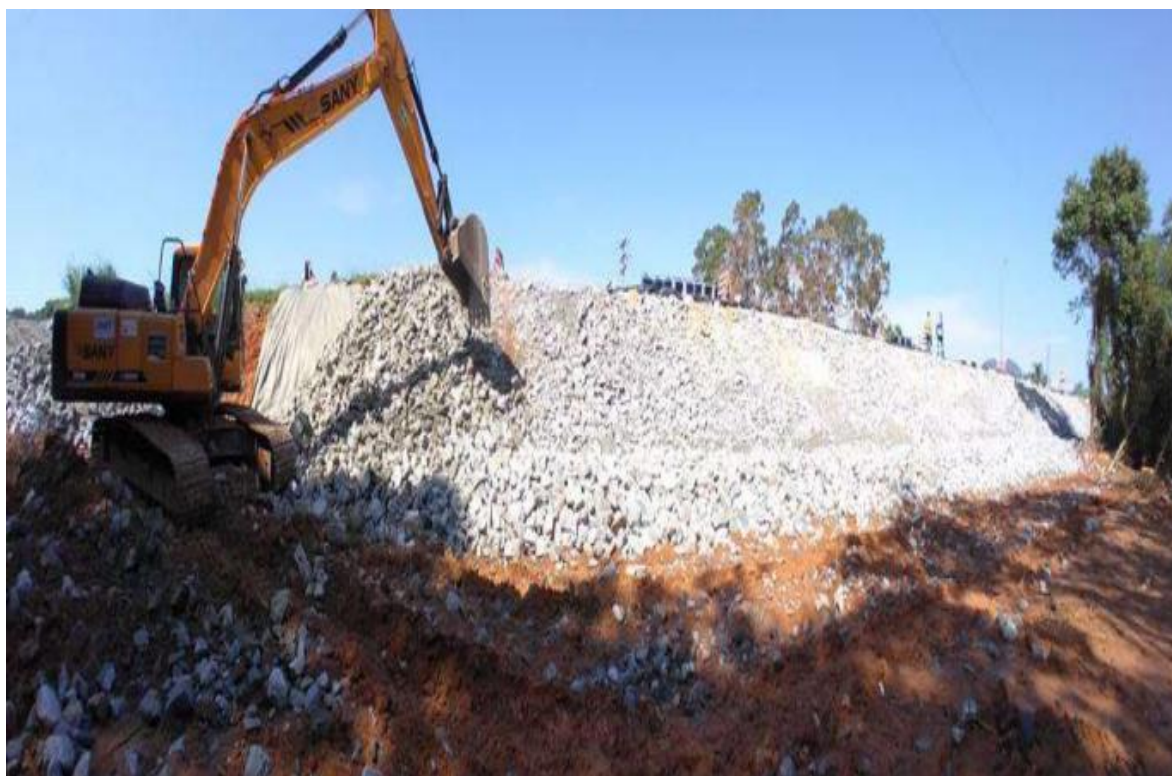
Figura 6.17 Via Lagos – Talude – Km 23+100 Sul
