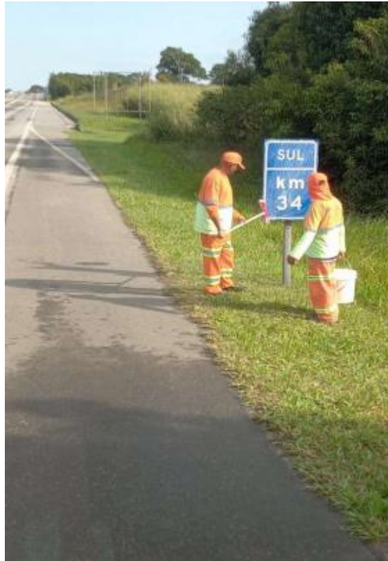
Figura 6.3 Via Lagos – Limpeza de placa – Km 34+000 Sul
