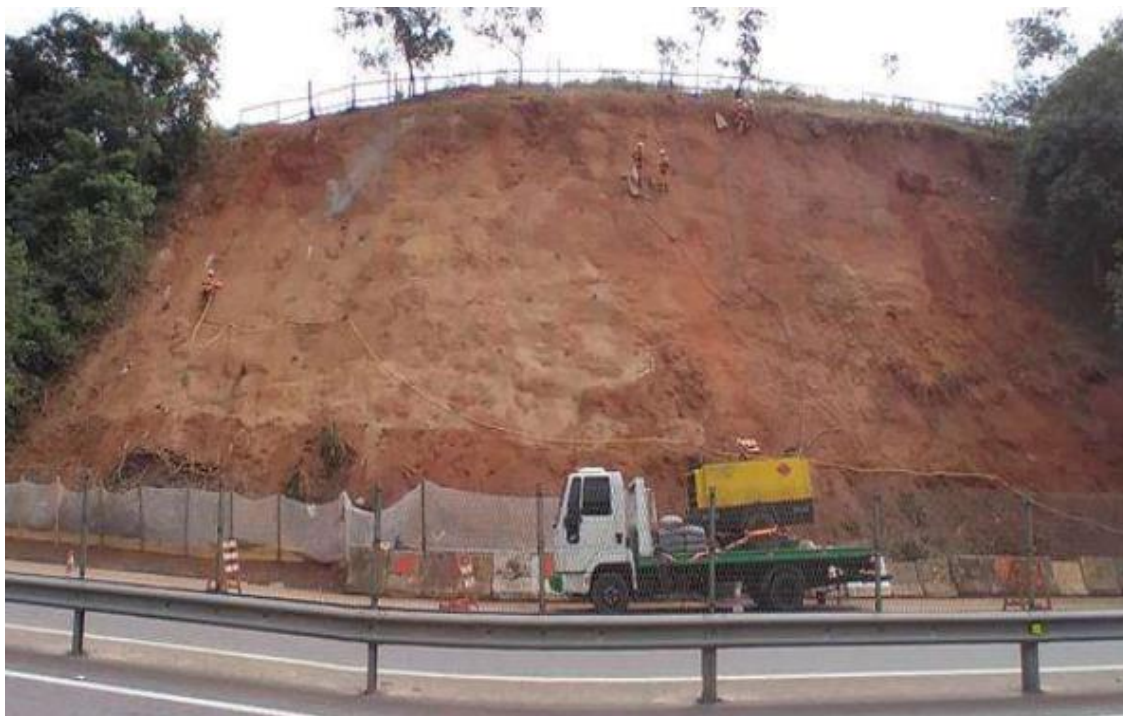
Figura 6.14 Via Lagos – Talude – Km 19+300 Sul
