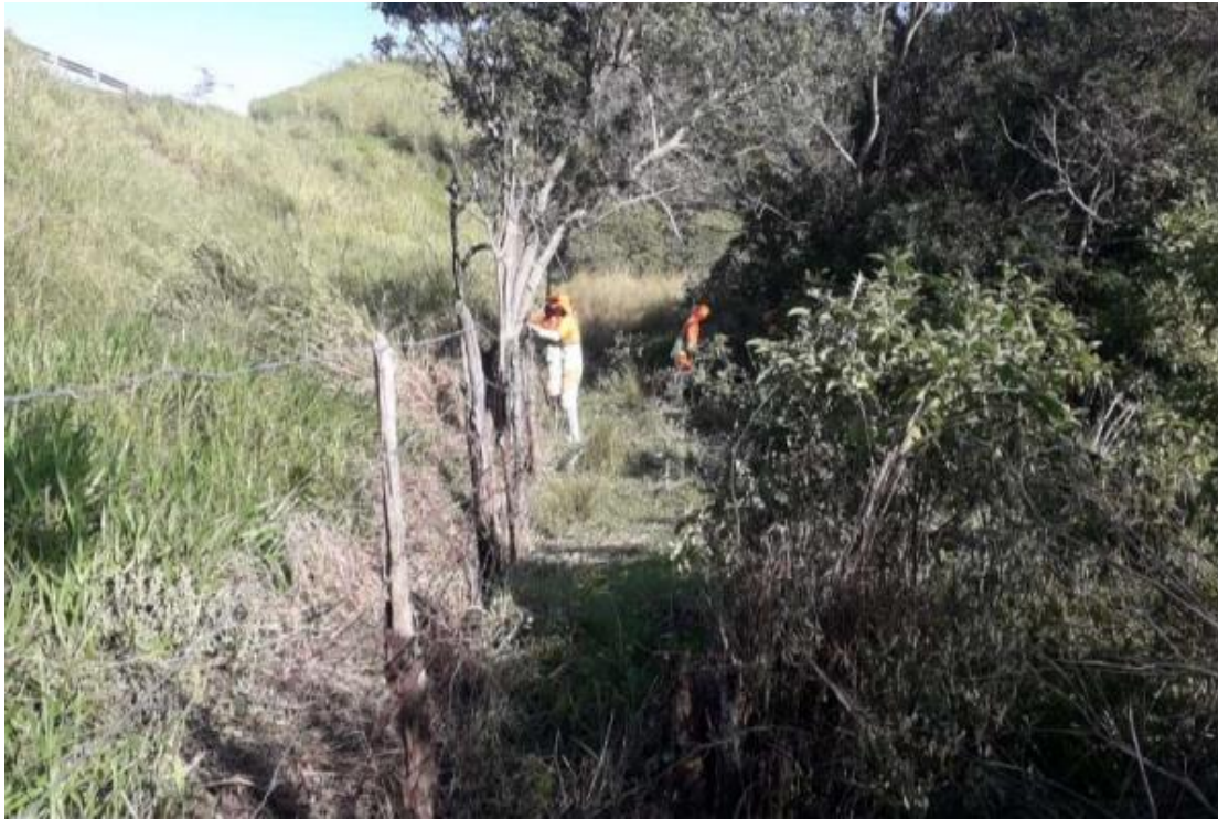
Figura 6.11 Via Lagos – Reparo de cerca – Km 50+000 Norte
