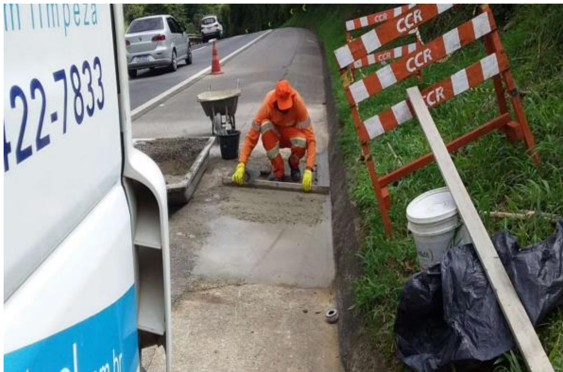
Figura 6.6 Via Lagos – Reparo de sarjeta – Km 2+500 Sul
