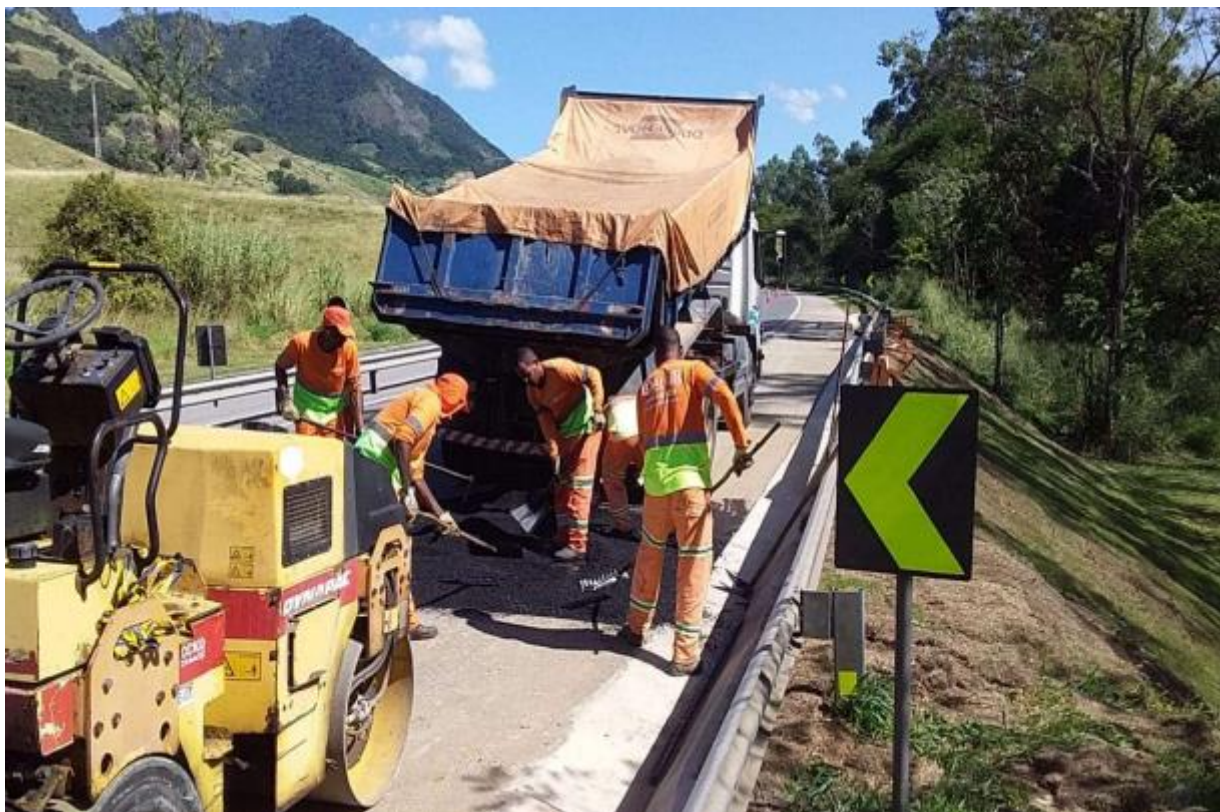
Figura 6.2 Via Lagos – Recuperação superficial de acostamento – Km 18+700 Sul
