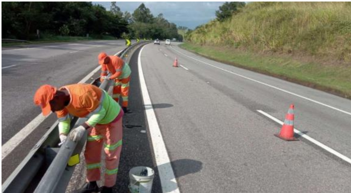
Figura 6.4 Via Lagos – Dispositivo de segurança – Km 18+000 Norte
