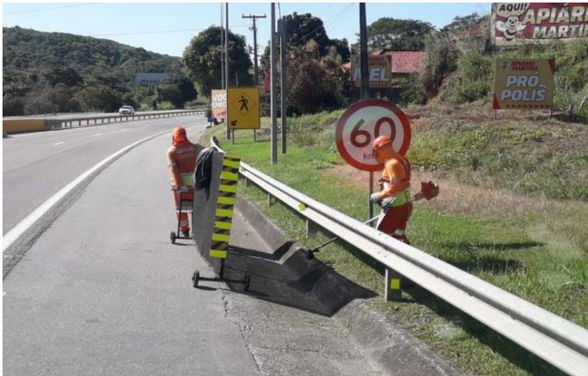
Figura 6.9 Via Lagos – Roçada manual – Km 19+900 Norte
