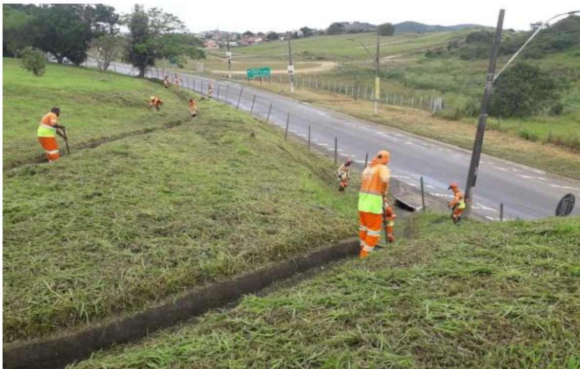
Figura 6.10 Via Lagos – Roçada manual – Km 47+400 Norte
