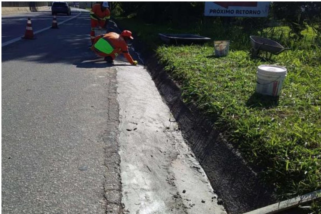
Figura 6.7 Via Lagos – Reparo de sarjeta- Km 14+000 Sul
