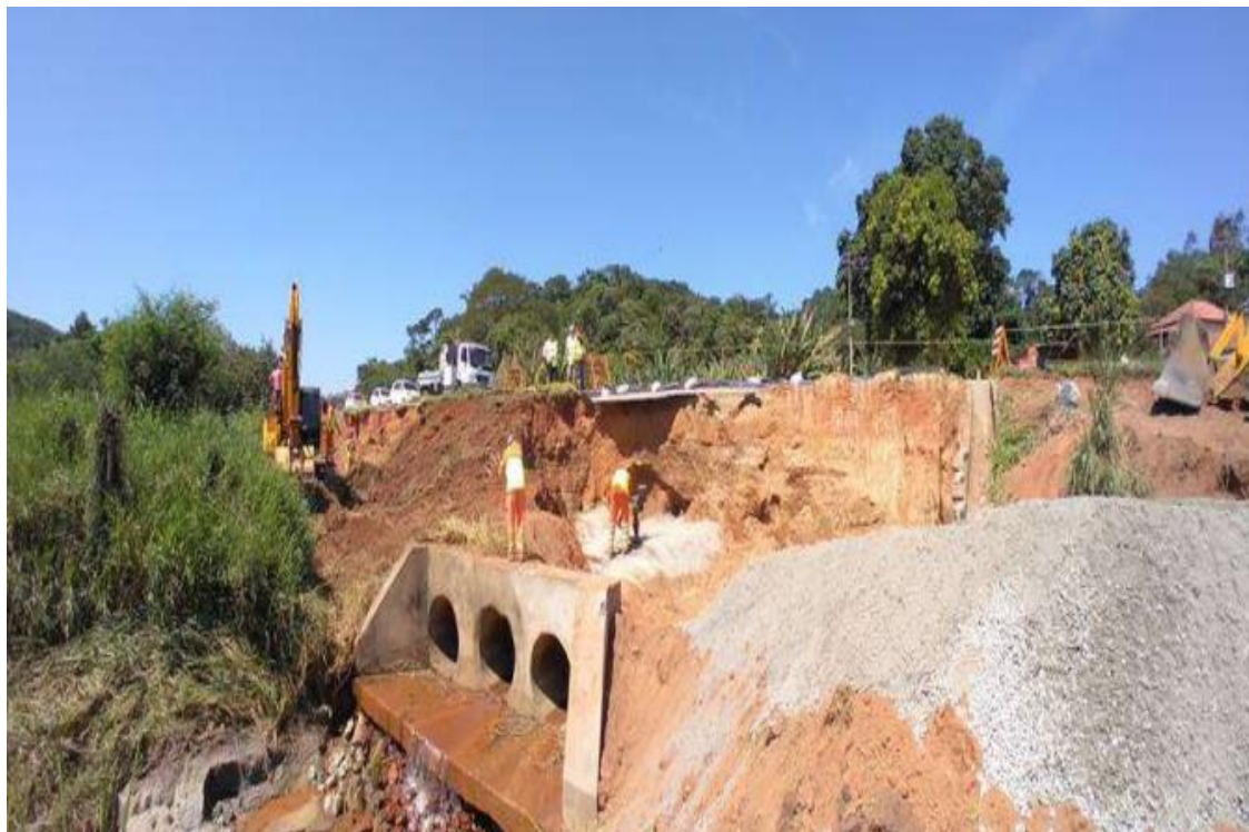
Figura 6.16 Via Lagos – Talude – Km 19+900 Sul
